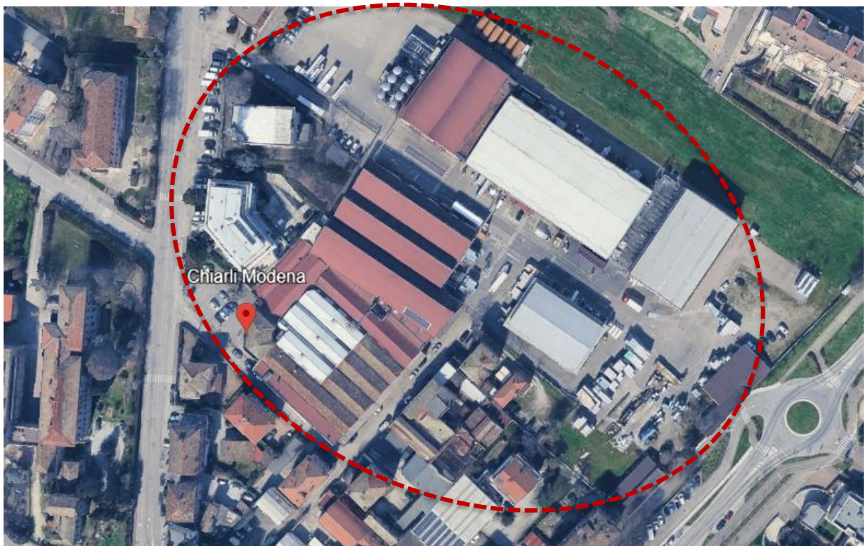
Figura 2 Ortofoto stabilimento PR.I.V.I. S.r.l. - Chiarli 1860 – sede di Modena (MO) (fonte: Google Earth)
